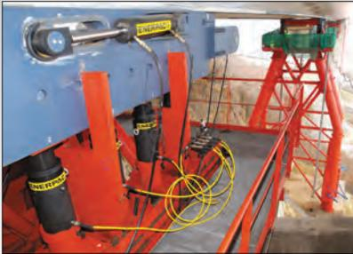
◀ Cilindros personalizados usados para sistemas de tendido de puentes en incrementos.
