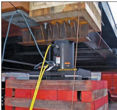
◀ Aplicación típica de elevación por etapas en la que se utiliza un sistema de Enerpac construido a la medida para levantar el puente de madera Akkerwinde, de 360 toneladas, en Holanda.
