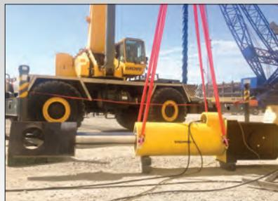
◀ Uno de tres cilindros especiales SyncHoist usado para colocar un módulo de 1,140 ton en una planta nuclear.
