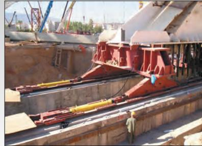
◀ Cilindros personalizados para operaciones de elevación con gato y de deslizamiento.
