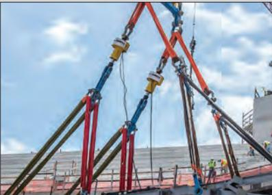
◀ Cilindros SyncHoist personalizados para la colocación del entramado de techos de estadios.
