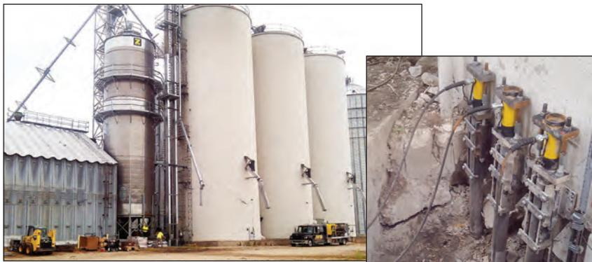
▼ Los accesorios de montaje para los cilindros RC incrementan notablemente la gama de aplicaciones (disponibles para cilindros de 5, 10, 15 y 25 toneladas).
