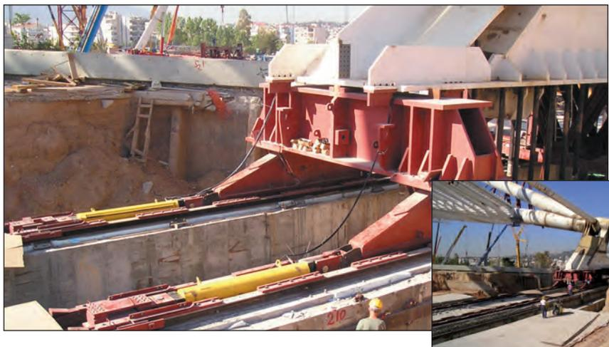
▼ Los cilindros RR brindan potencia y precisión en una prensa hidráulica especial.
